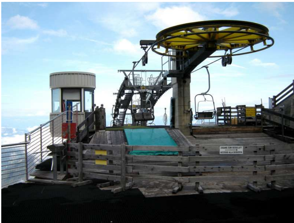
Bergstation des Sesselliftes Laurin II (Rosengarten, Dolomiten)
