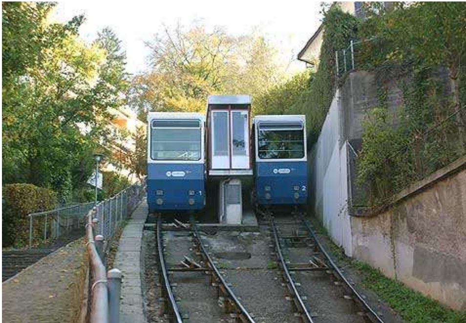
Seilbahn Rigiblick (Ausweichstelle Hadlaubstraße), 8006 Zürich
