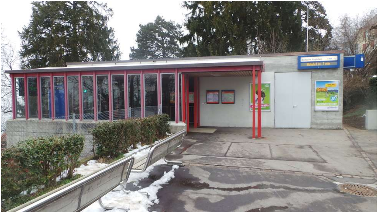
Seilbahn Rigiblick (Bergstation), 8006 Zürich
