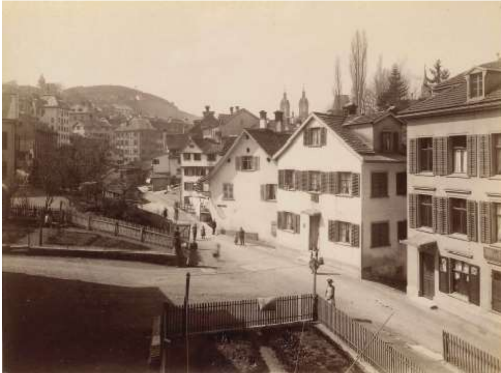
Mittlere Lämmlisbrunnenstraße, 9000 St. Gallen (1894)
