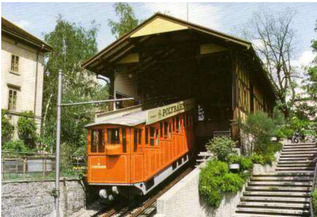
Polybahn (Bergstation), 8001 Zürich
