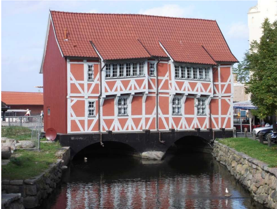
Brückenhaus in Wismar
